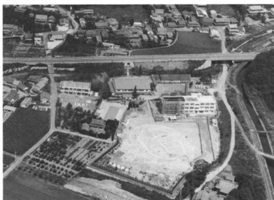
完成間近の第2期工事（昭和56年）
