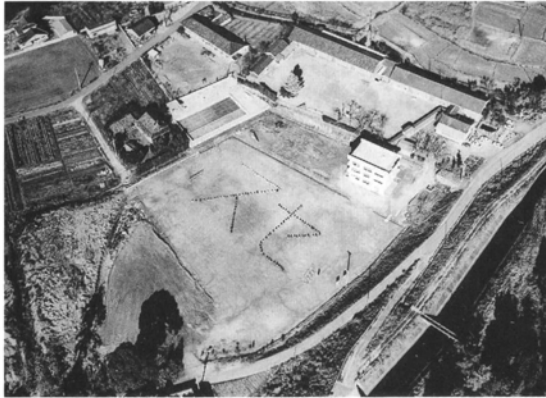
拡張工事中の校庭（昭和48年）
