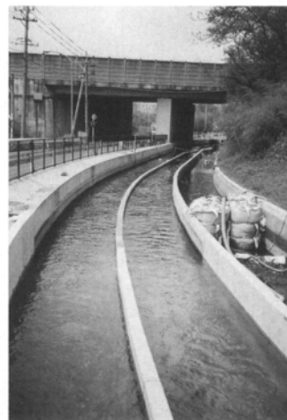
施工中の牟呂用水 平成18年（2006）
