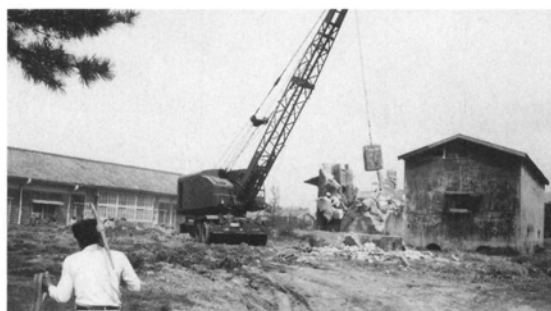
残っていた軍施設の取壊し 昭和39年4月
