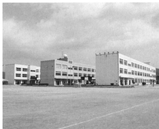
鉄筋校舎（平成17年）
