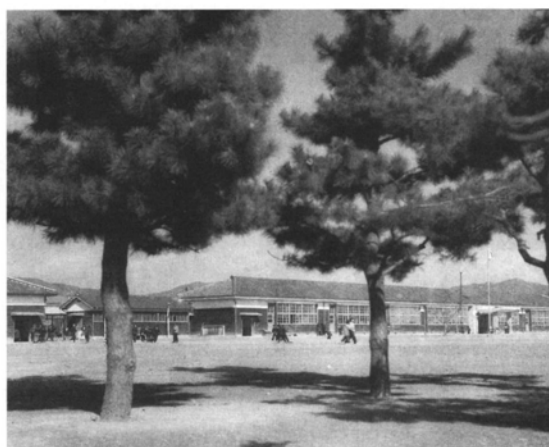
懐かしい木造校舎（昭和29年）
