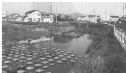
合流点 (山中川と殿田川が 合流し、柳生川 (手前)となる)
