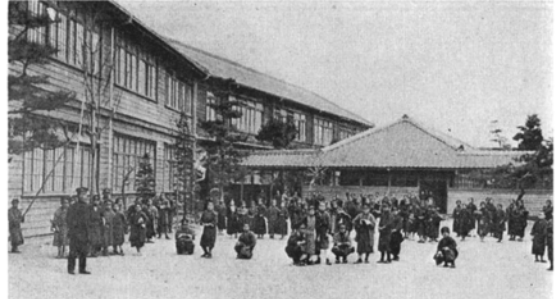
木造2階建校舎第2棟
