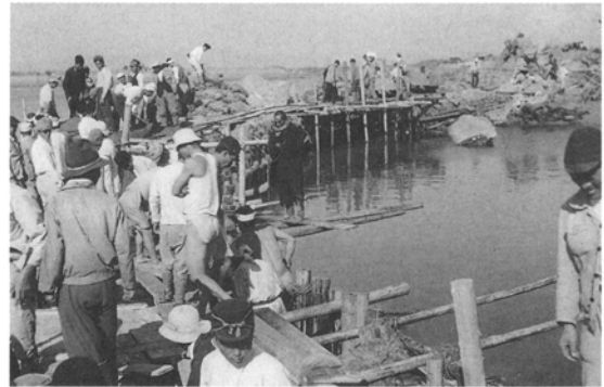
13号台風被害の堤防復旧工事
