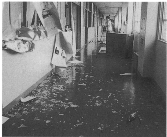
高師小学校教室被害
