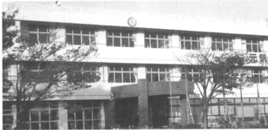
完成した校舎
