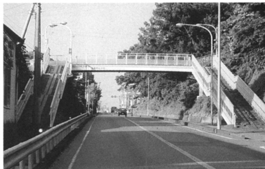
松井町内の国道259号線の歩道橋
