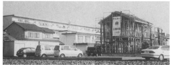
畑の中に建てられた住宅
