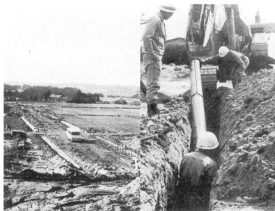
団地造成工事 1
