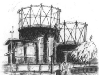
西駅前ガスタンク（昭和50年）
