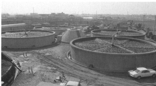
羽根井処理場（羽根井ポンプ場）
