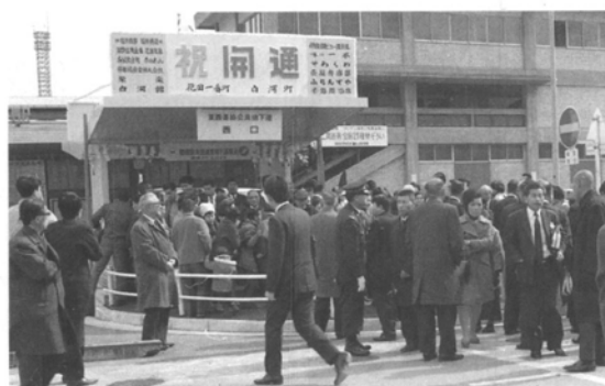
西駅側からの地下道（昭和46年）
