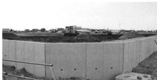
2-12 造成工事が完了した建設用地
