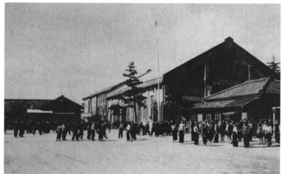
3-2 昭和8年にできた鉄筋コンクリート造の講堂
