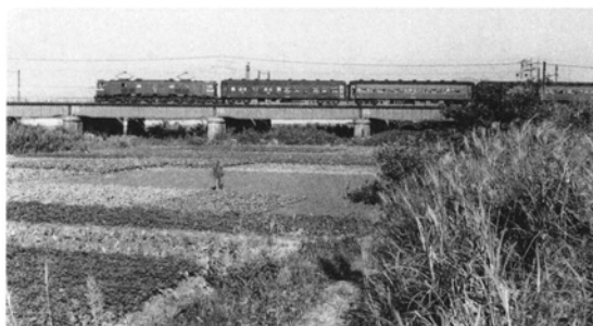
2-7 明治41年に複線化された東海道線の豊川橋梁
