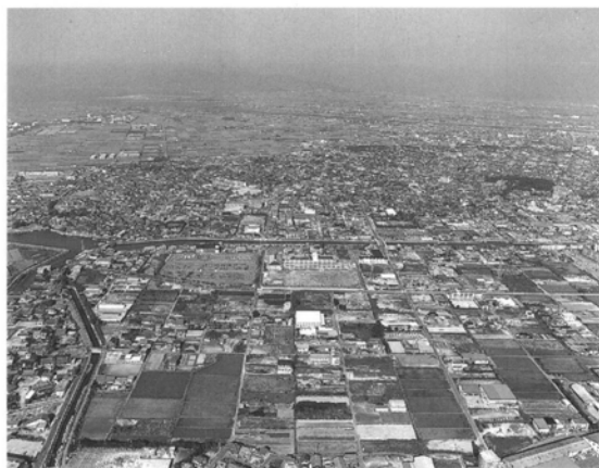
校区全景（南から見る）
