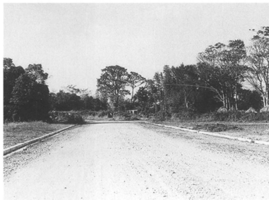
1・3・3 豊橋港線の工事 中西三知雄氏撮影 （現 東脇信号交差点付近を東から見る）
