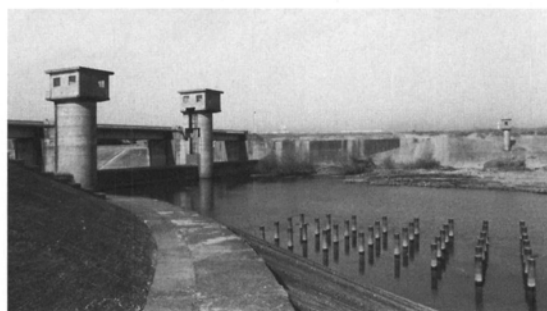
豊川放水路の分流堰
