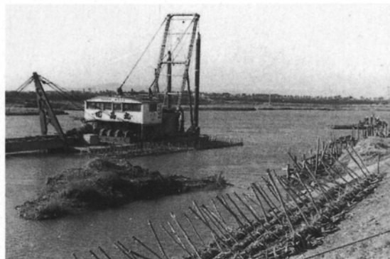
放水路築堤工事の様子
