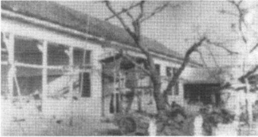
被害を受けた園舎
