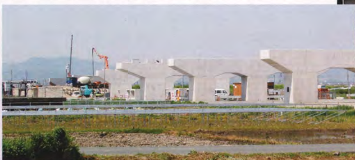
校区内に建設が進む「名豊道路」 豊川橋から北に延びる橋梁工事が進められている。
